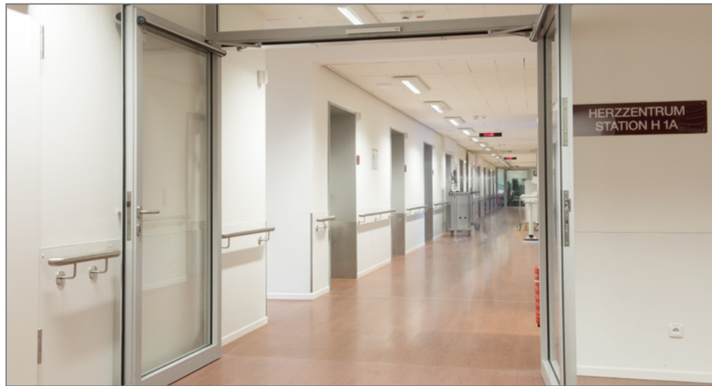
Bild 1 Bequemer Bettentransport: Weitaufschwingende 2-flügelige, automatisierte Aluminium-Türelemente mit großzügigen Glasflächen. Der Öffnungsimpuls erfolgt manuell im Vorfeld der Tür per Handtaster.
