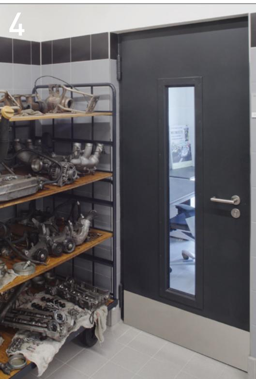
**Bild 4** Rauchdichte Feuerschutztür T30-1N2/50 mit Brandschutzverglasung
