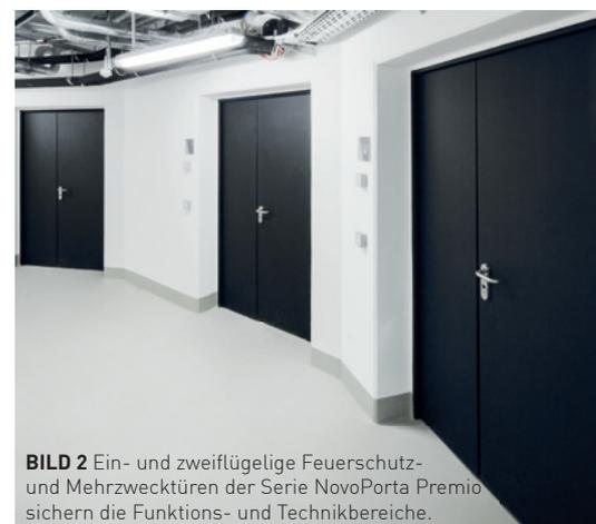
**BILD 2** Ein- und zweiflügelige Feuerschutz- und Mehrzwecktüren der Serie NovoPorta Premio sichern die Funktions- und Technikbereiche.
