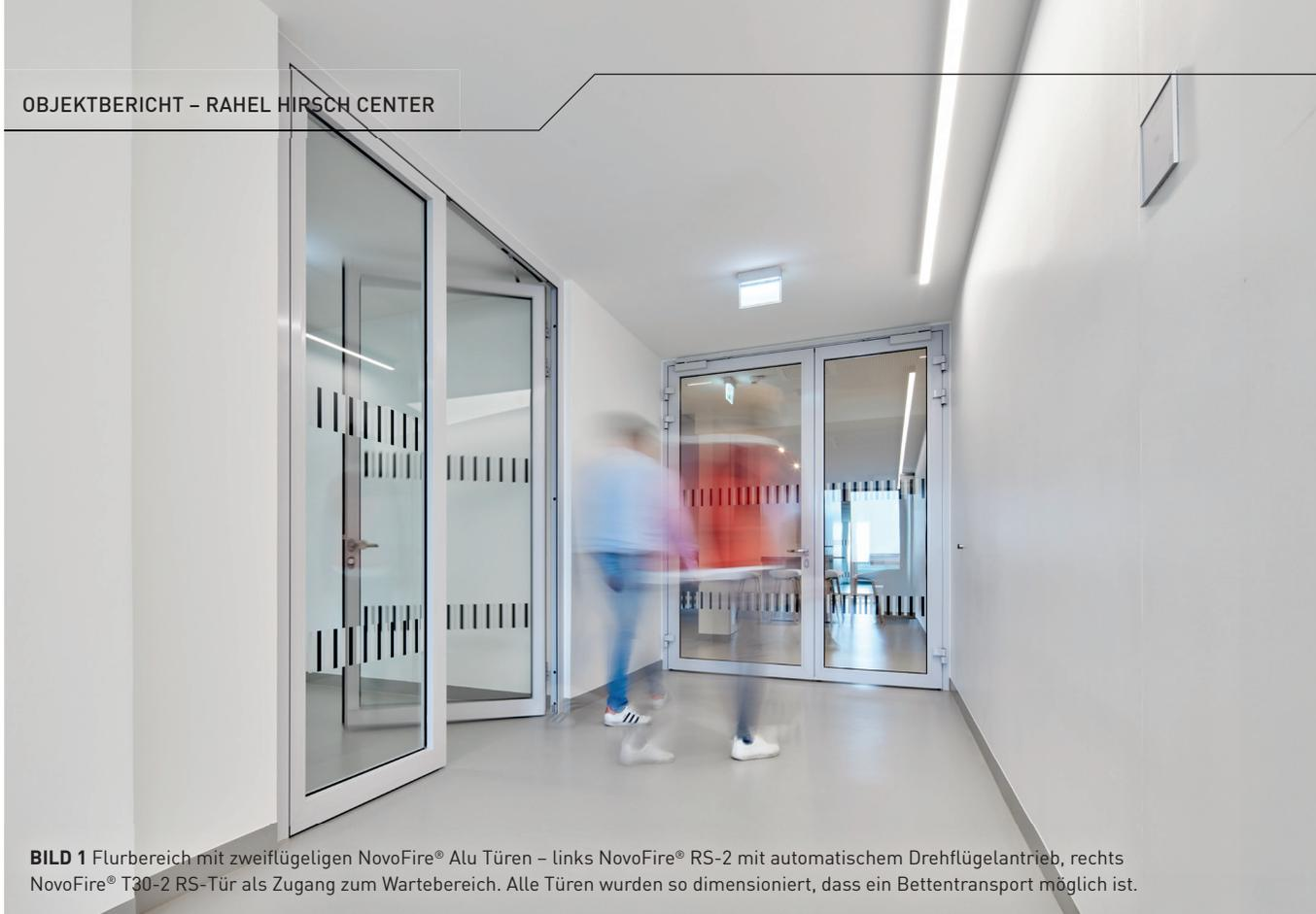
**BILD 1** Flurbereich mit zweiflügeligen NovoFire® Alu Türen – links NovoFire® RS-2 mit automatischem Drehflügelantrieb, rechts NovoFire® T30-2 RS-Tür als Zugang zum Wartebereich. Alle Türen wurden so dimensioniert, dass ein Bettentransport möglich ist.
