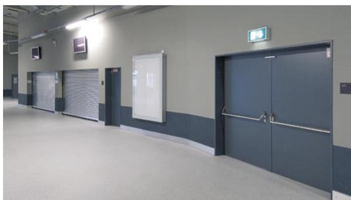
**Rolltore** schließen nach Geschäftsschluss die Verpflegungs- bzw. Verkaufsareale hermetisch ab. Bei diesem Objekt kamen TH80-Rolltore mit doppelwandigen, wärmedämmend ausgeschäumten Lamellen aus Alu natur mit Klarlackbeschichtung zum Einsatz.
