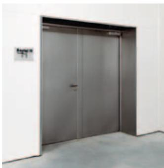
Mehrere T30-Türen wurden aus Simulationsgründen mit fehlendem Türschließer bzw. fehlendem Typschild eingebaut. In der Praxis wäre diese Bauart nicht zugelassen.
