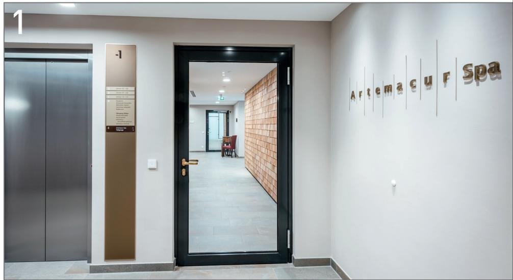
**Bild 1** NovoFire T90-1 RS zur Sicherung der Brandabschnitte im Flur-Bereich und Aufzug.
