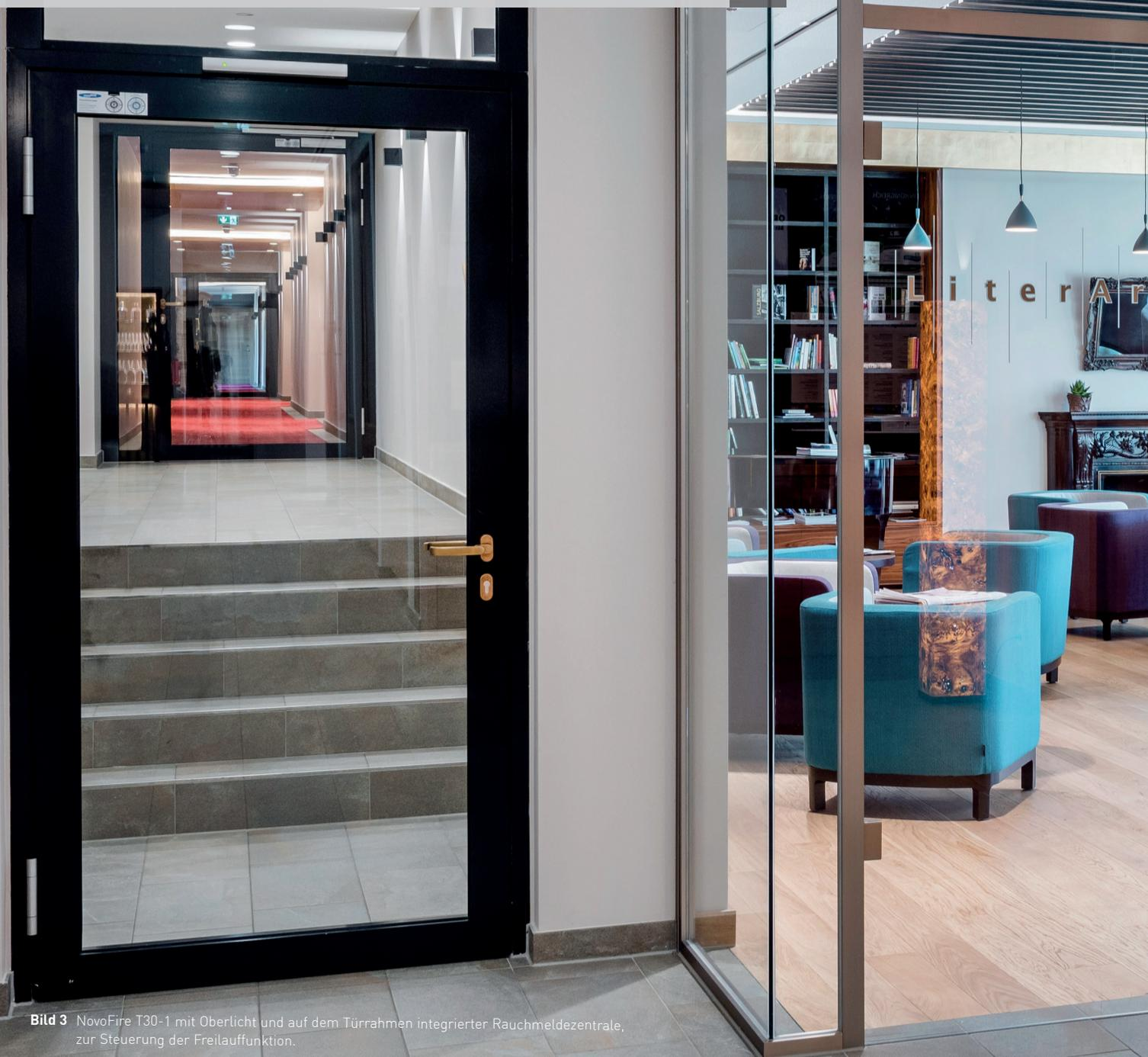
**Bild 3** NovoFire T30-1 mit Oberlicht und auf dem Türrahmen integrierter Rauchmeldezentrale, zur Steuerung der Freilauffunktion.
