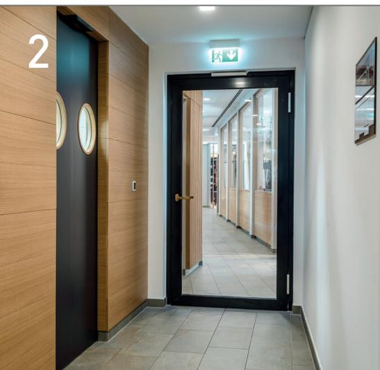
**Bild 2** NovoFire T30-1 RS Ausführung mit Rollenband.
