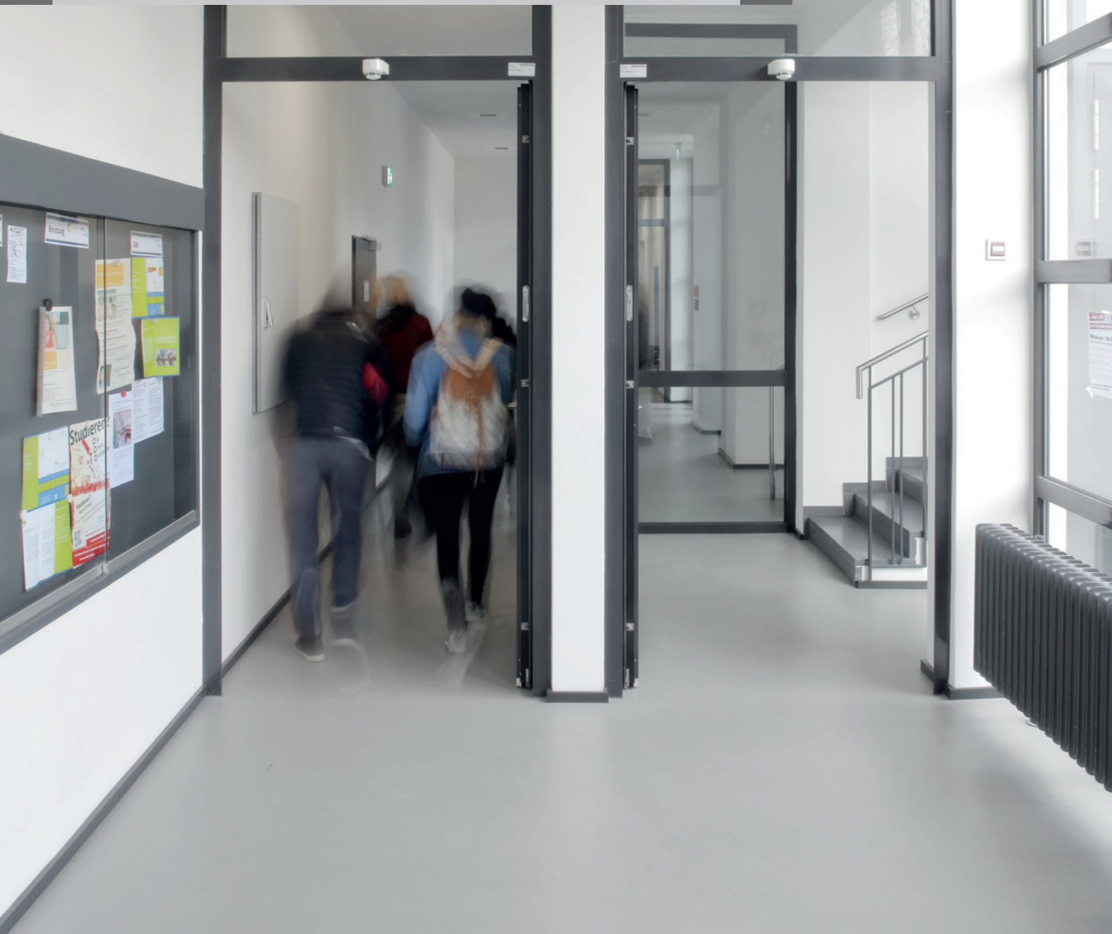
Bild 3 Brandabschnitt zum Treppenhaus gesichert durch eine NovoFire Festverglasung F90 und zwei NovoFire T30-1 Türen mit elektromechanischer Offenhaltung für einen barrierefreien Durchgang.
