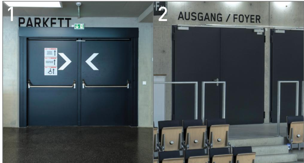
**Bild 1** 2-flügelige T30-Rauchschutztür T30-2 N22 mit Vollpanikfunktion nach DIN EN 1125 mit Griffstangen
