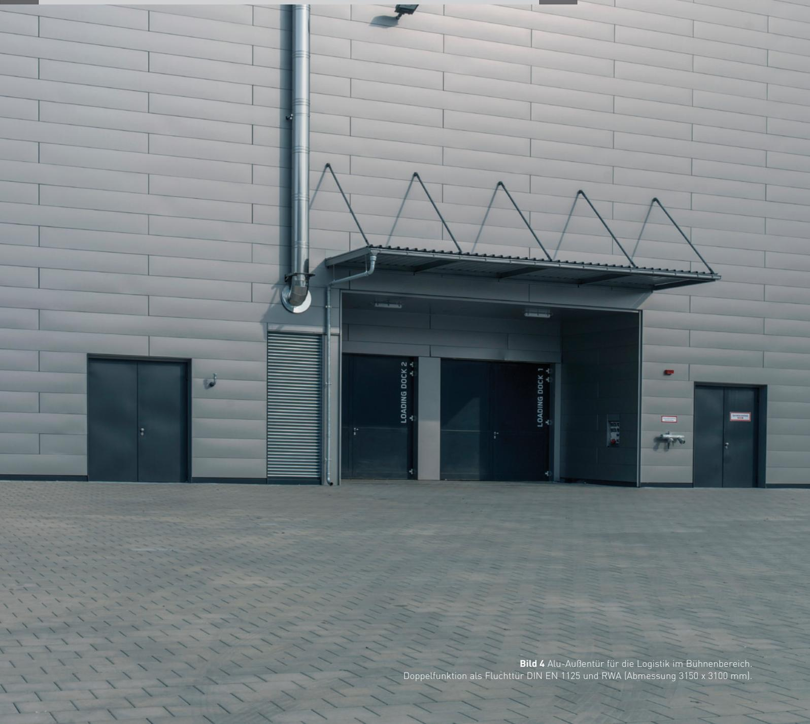
**Bild 4** Alu-Außentür für die Logistik im Bühnenbereich. Doppelfunktion als Fluchttür DIN EN 1125 und RWA (Abmessung 3150 x 3100 mm).
