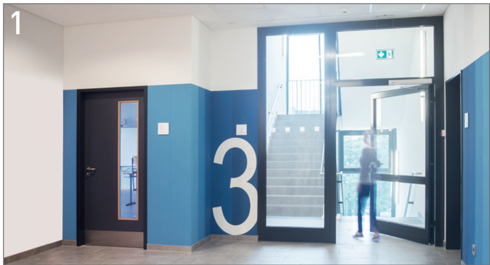
Bild 1 Fluchtweg zum Treppenhaus: Brandschutztür T30-1 RS mit großem Türflügel und großflächiger Verglasung zur optimalen Nutzung des Tageslichts.
