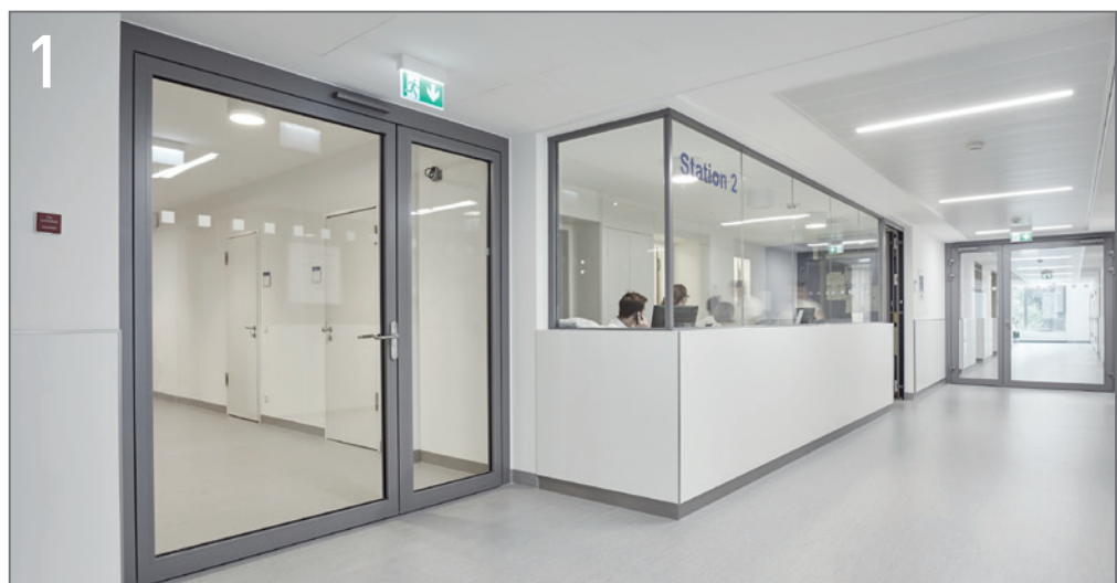
Bild 1 Stationstür NovoFire® T30-2 mit elektrischen Haftmagneten zur Offenhaltung im Tagesbetrieb.
